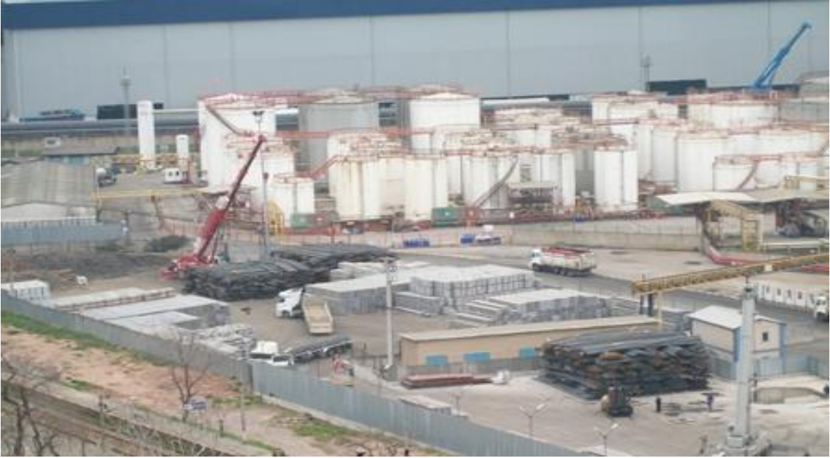
Şekil 3 Tesisin Dış Görünüşü 2
