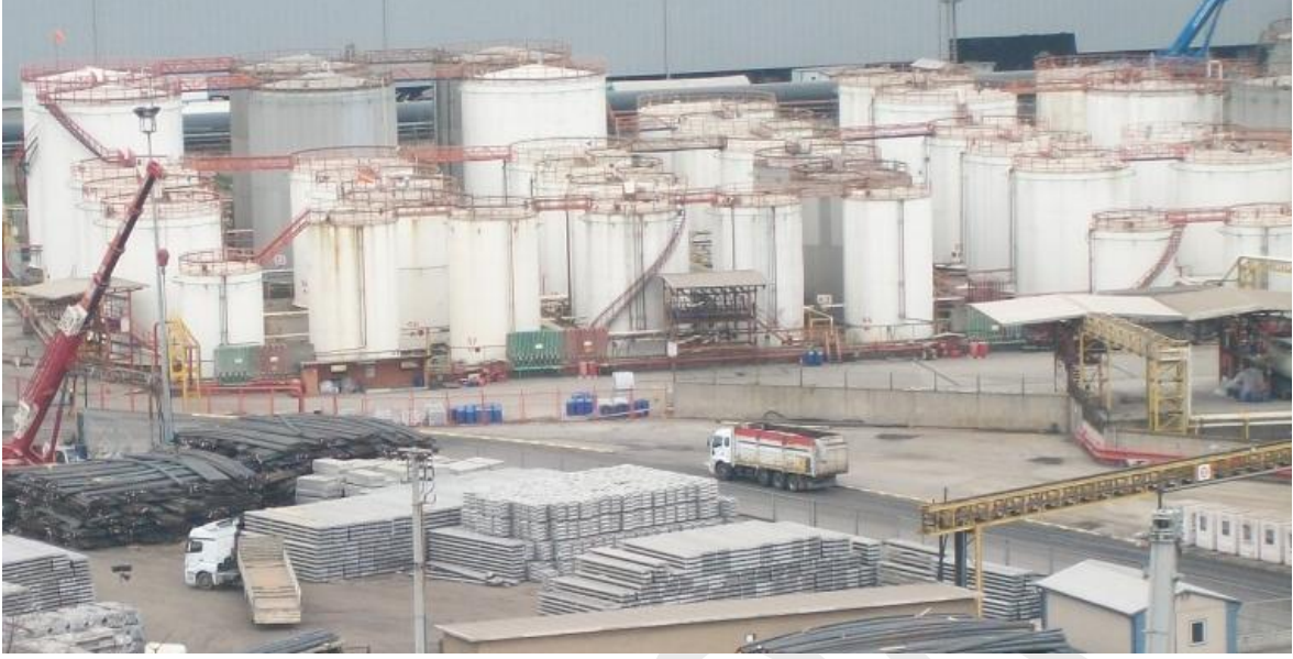
Şekil 2 Tesisin Dış Görünüşü 1
